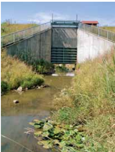
Durchlassbauwerk am Rückhaltebecken Oberdorf
