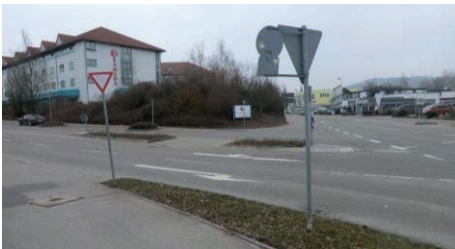
Daimlerstraße / Benzstraße: Der Radweg ist verschwenkt und hat Nachrang
