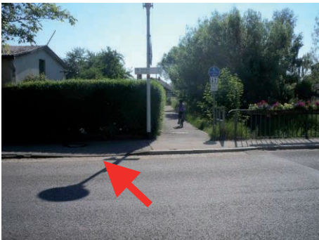
Gültstein, Ammertalweg: Die Bordsteinabsenkung ist an der falschen Stelle
